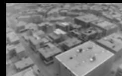
CONSTRUCCIÓN DE CUBIERTAS
